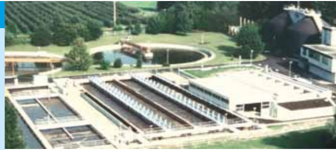
Sewage plant Eriskirch Abwasserverband Unteres Schussental
