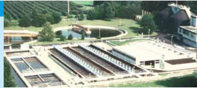
Kläranlage Eriskirch Abwasserverband Unteres Schussental
